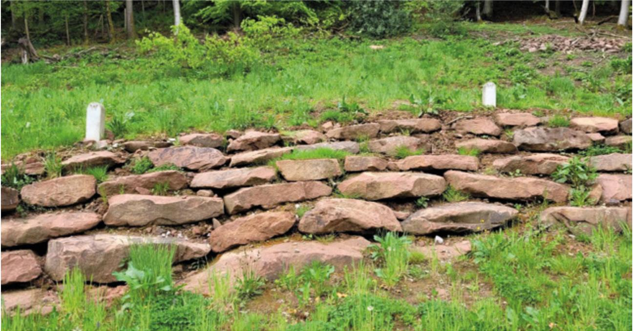
*Zur Hangsicherung konnten die bei den Arbeiten anfallenden Sandsteine weiter verwendet und somit je Quelle eine naturnahe Sandsteinmauer hergestellt werden*
