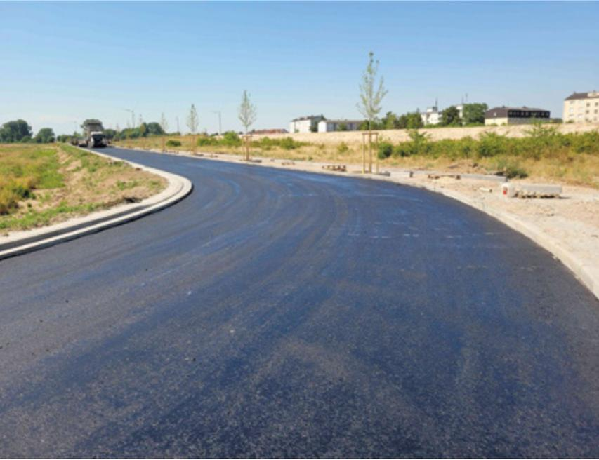
*Einbau Asphalttragschicht in Erschließungsstraße*
