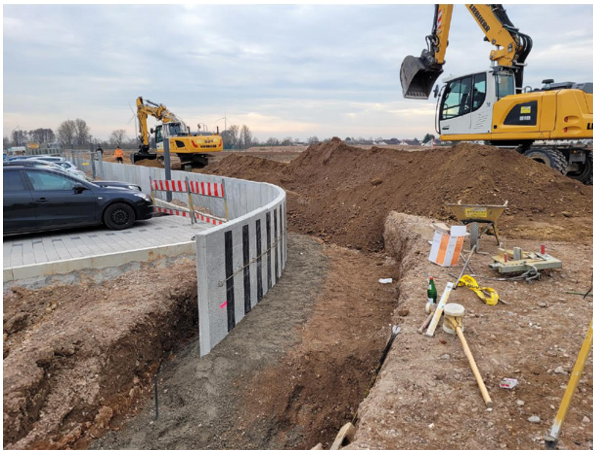
*Herstellung Winkelstützmauer zur Abfangung der Böschung des Straßenkörpers an bestehenden Anlagen (Parkplatz)*
