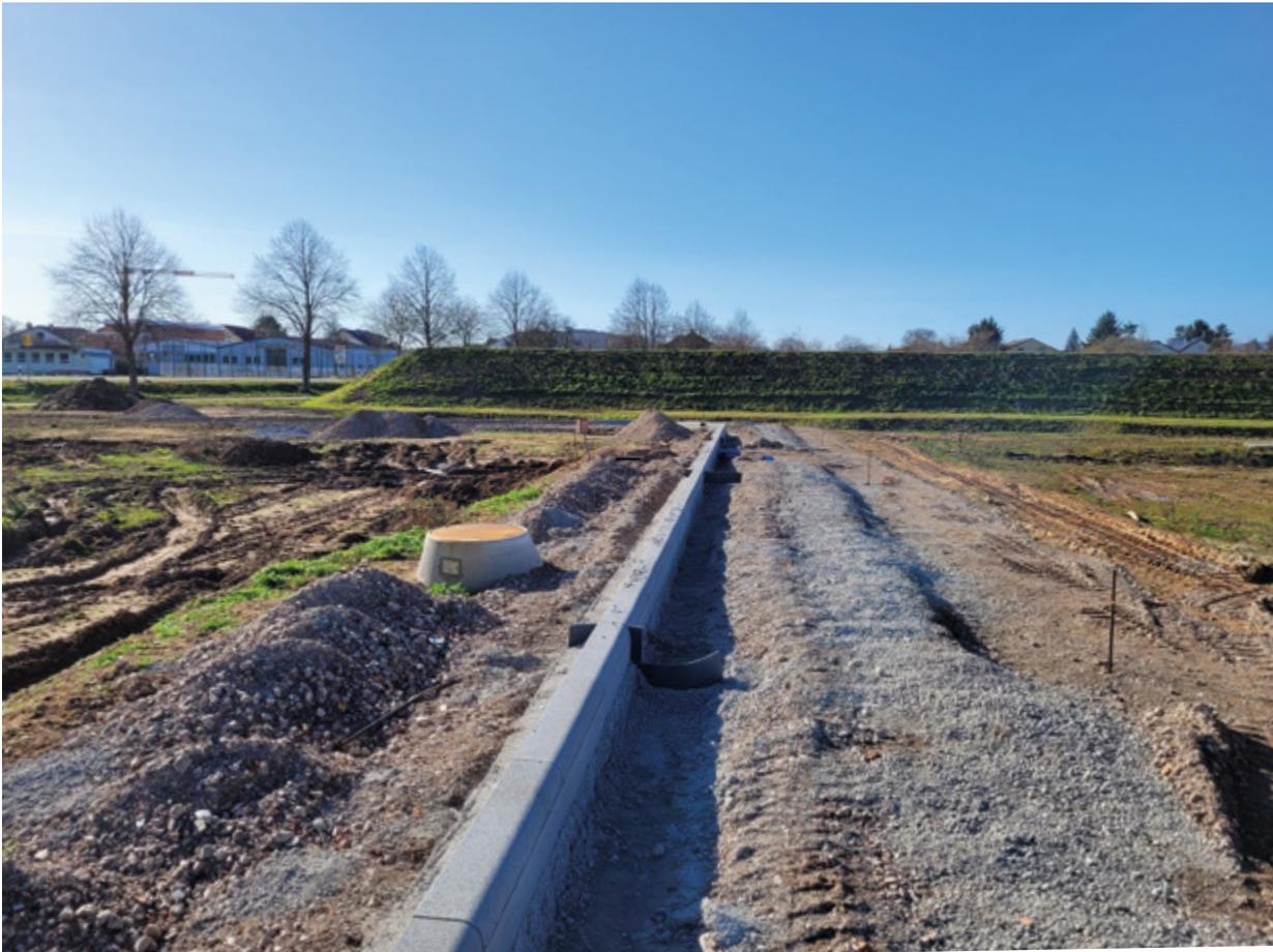
*Im Vordergrund: Herstellung von Bordanlagen für Geh- und Radwege, im Hintergrund: begrünter Lärmschutzwall*
