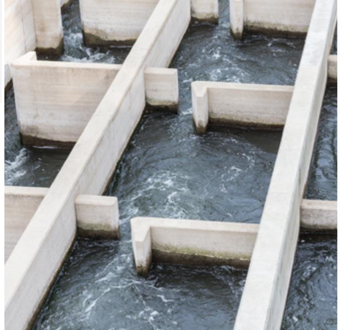
Regulierbauwerk waren jedoch für hohe Wasserstände unterschätzt, so dass sich für den Betrieb aufgrund der Ergebnisse der 3D-Hydraulik etwas geringere Öffnungshöhen am Schütz ergeben. Die maximalen Fließgeschwindigkeiten für eine Durchwanderbarkeit durch die maßgebenden Fischarten werden nur punktuell leicht überschritten und sind damit unkritisch.
